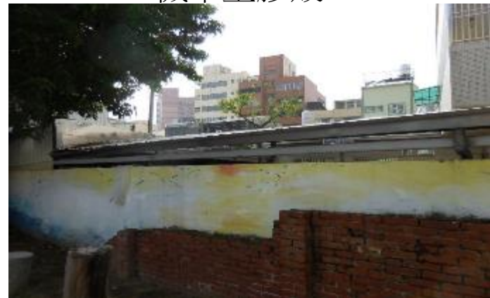
天溝(屋簷排水槽)
