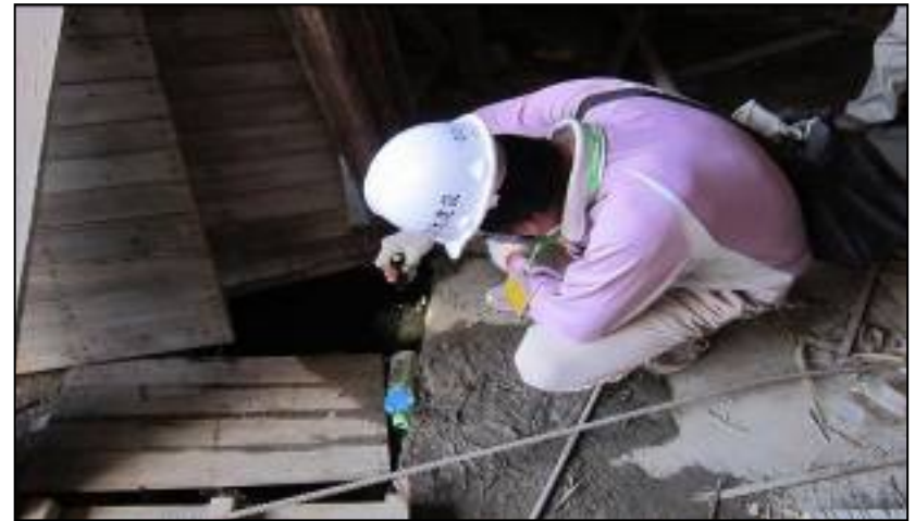
車道下方水溝
