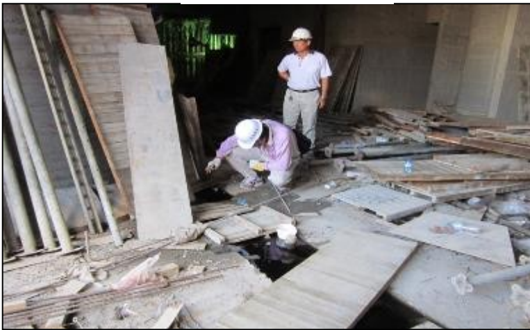
車道下方水溝
