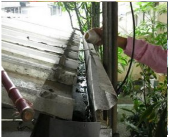
天溝(屋簷排水槽)
