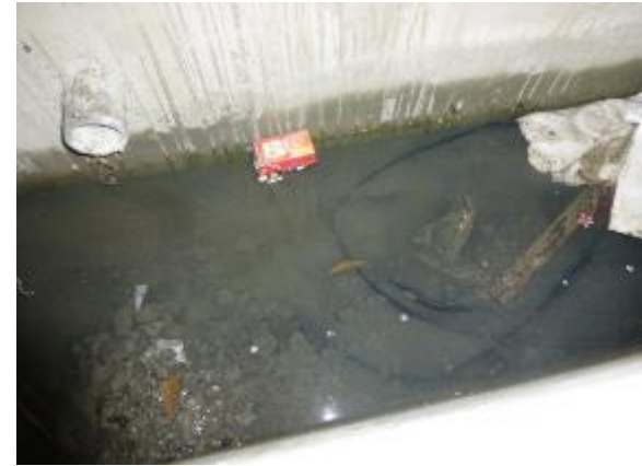
建築工地地面
