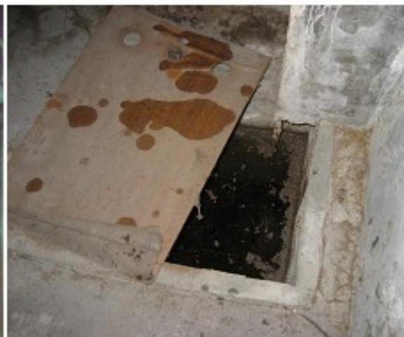
地下室污水池
